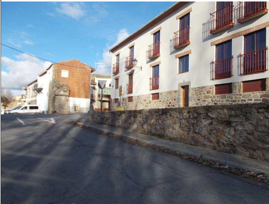
Muralla en la Calle la Regadera y restos en la Puerta del Puente
